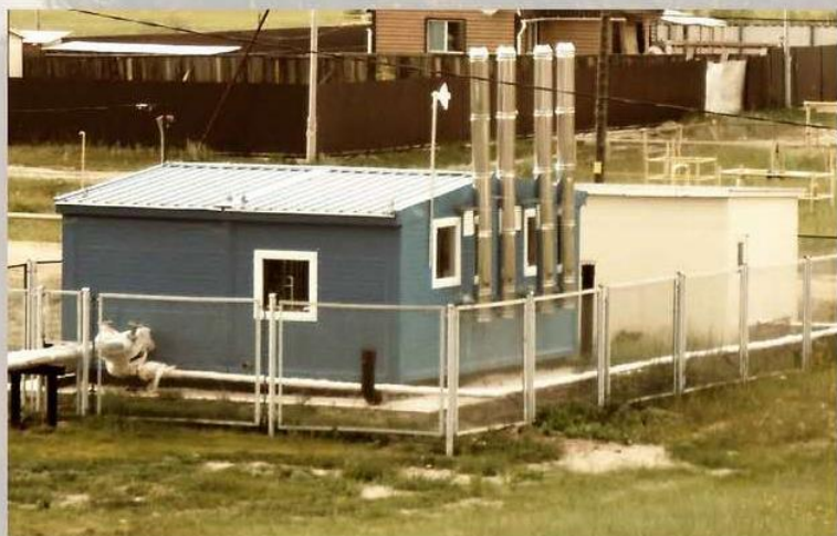
Модульная газовая котельная г. Новосибирск с 4 котлами "Viessman" по 150 кВт (600кВт)
